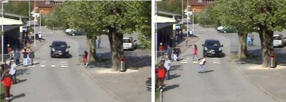
Abbildung 4.5: Ein Vertikalversatz vor einem Schulhauszugang sichert die Einhaltung von Tempo 30 und erlaubt flächiges queren bei Schulanfang. Auf das Aufmalen des Fußgängerstreifens wurde unterdessen hier verzichtet.
